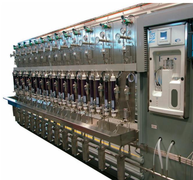
Panneau d'échantillonnage avec un analyseur de sodium
